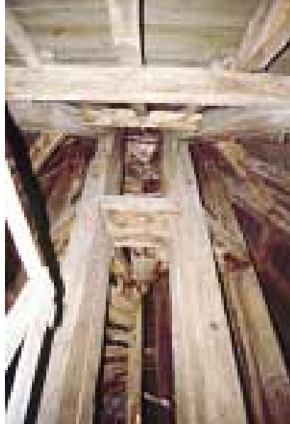
Imagen 317. Torre. Nivel 6. Estructura del chapitel
