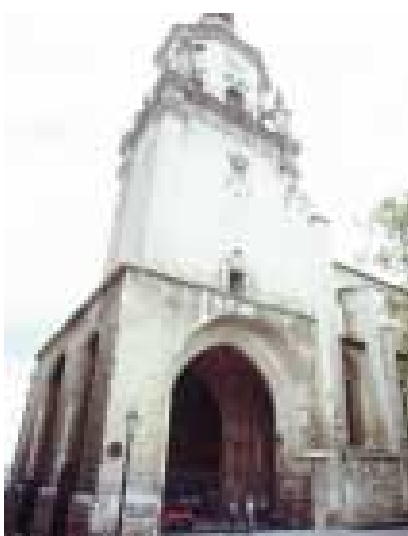
Imagen 315. Torre. Vista exterior
