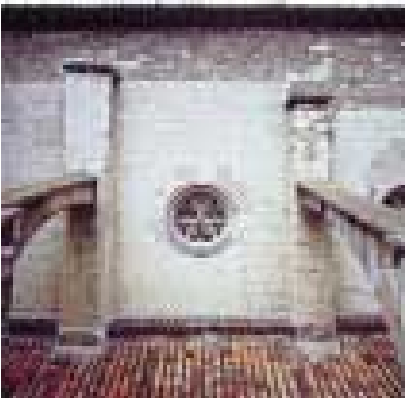
Imagen 181. Muro de doble hoja de sillaría de lumaquela de ajarte, de aparejo cuadrangular con hiladas de regulación, en el segundo tramo del alzado oriental de la nave, siglo XV. El remate superior corresponde al recrecido de mampostería con sillaría reutilizada realizado en el siglo XVII para construir la cubierta de madera. En el centro del paño esta insertado un rosetón de la restauración del siglo XX con sillaría de arenisca
