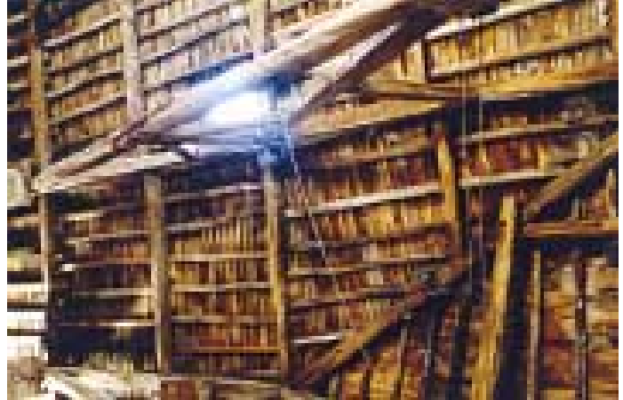
Imagen 294. Vista de estructura secundaria
