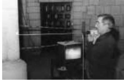
Imagen 137. Inspección visual del interior de un pilar realizada con un boroscopio
