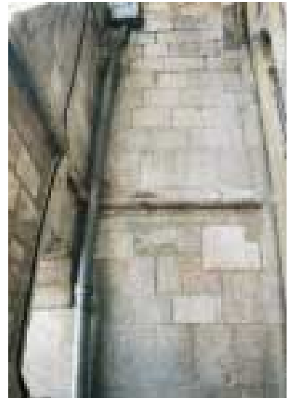
Imagen 219. Bajante de zinc en fibrocemento en el pasillo de ronda
