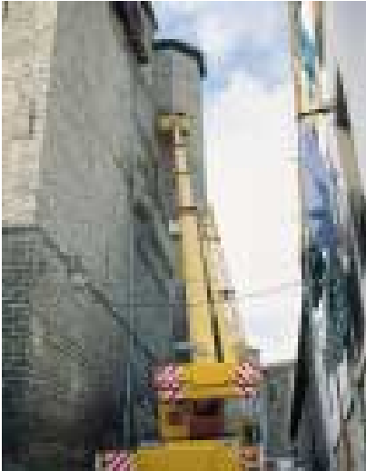
Imagen 247. Aspectos del muestreo. Accediendo mediante la grúa a la repisa del muro del transepto norte, sobre el Paseo de Ronda (punto de muestreo nº 14 y área afectada nº 16)
