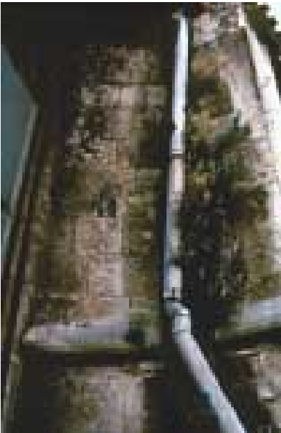
Imagen 2. Aspecto del exterior de una de las capillas de la girola
