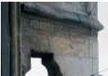
Perfil con frente bajo achaflanado, bisel superior y goterón
