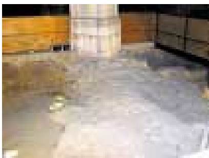
Imagen 166. Vista de la zapata del pilar H2 en el lado sur entre el 2 y 3 tramo de la nave
