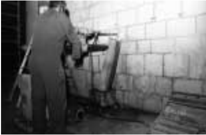
Imagen 140. Perforación con extracción de testigos; análisis del testigo
