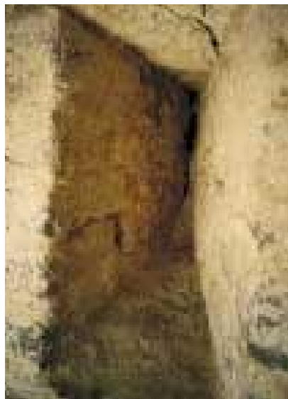
Ventana con derrame interior
