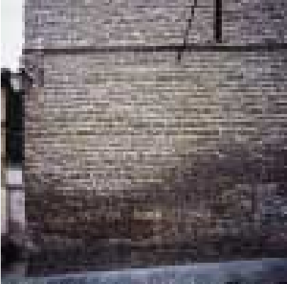
Imagen 178. Muro de doble hoja de mampostería de lajas y sillarero, de 3,5 m de espesor, perteneciente al proyecto iniciado por Alfonso VIII, en el lienzo septentrional de la esquina NE del edificio
