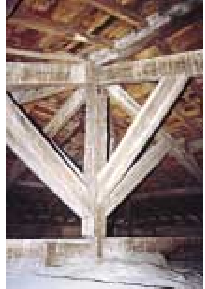
Imagen 318. Nave principal norte
