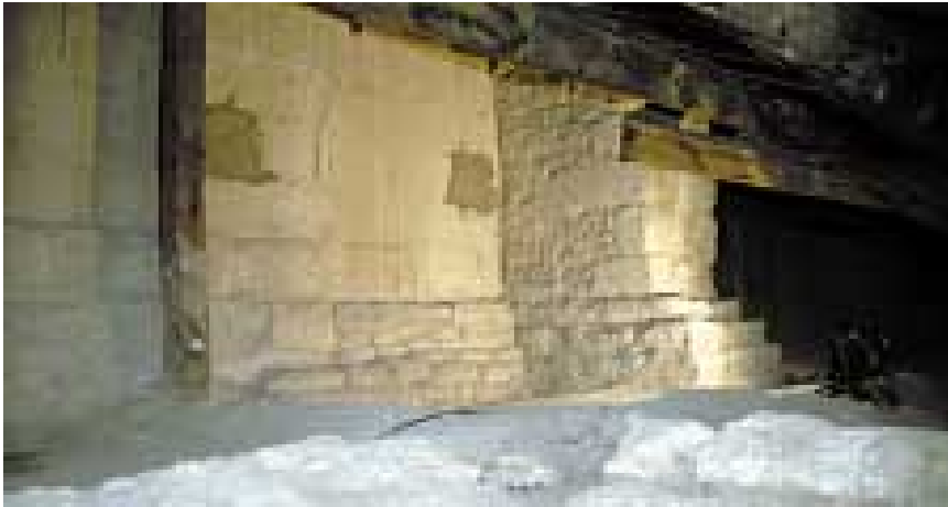
Imagen 207. Izquierda, detalle del apoyo de uno de los contrafuertes del alzado sur en el interior del bajo cubierta de la nave lateral. Se puede observar como el contrafuerte amplía su apoyo sobre los rellenos de los senos de las bóvedas, como si fuese una zapata de un pilar que fuese a apoyar en el suelo
