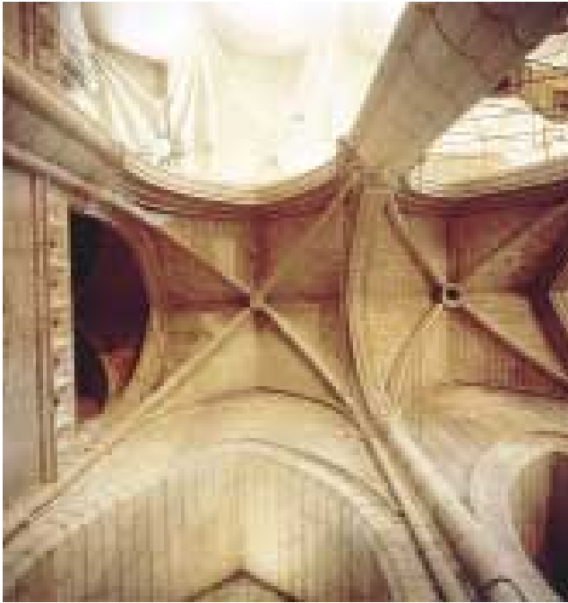
Imagen 211. Izquierda, bóveda del segundo tramo de la nave lateral sur
