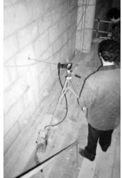
Imagen 139. Registro fotográfico de la inspección realizada con un boroscopio en un muro
