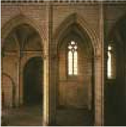
Imagen 177. Vista frontal de los pilares (H2, G2) del tercer tramo de la nave
