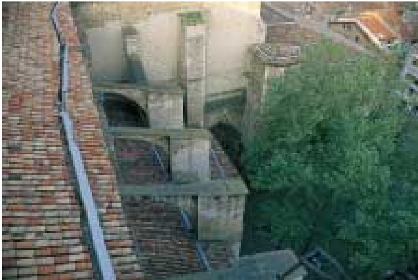
Imagen 217. Deterioro del canalón de la fachada sur
