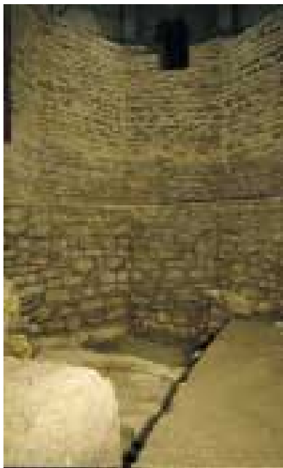
Imagen 83. Ábside norte: puede apreciarse la construcción hexagonal en su arranque y el cambio de trazado octogonal en la parte superior
