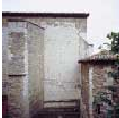
Imagen 184. Diferentes aparejos en el muro de doble hoja de sillería de lumaquela de ajarte, del alzado occidental del transepto sur, siglo XVI. Aparejo convencional a soga y sillería con gafas de elevación. En el centro se puede observar el gran estribo de mampostería reforzado con sillares en las esquinas, construido por Saracibar en el siglo XIX y transformado con la obra de restauración del siglo XX para liberar la portada de Santa Ana. A este mismo periodo corresponde el remate del torreón octogonal, con una fábrica de mampostería con sillares en las esquinas y mortero de cemento que imita los aparejos antiguos
