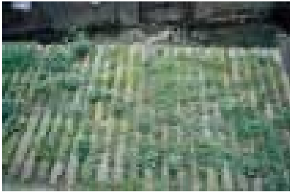
Imagen 250. Aspecto del tejado de la "casita" adosada a la fachada norte (área afectada nº 23), con abundantes herbáceas
