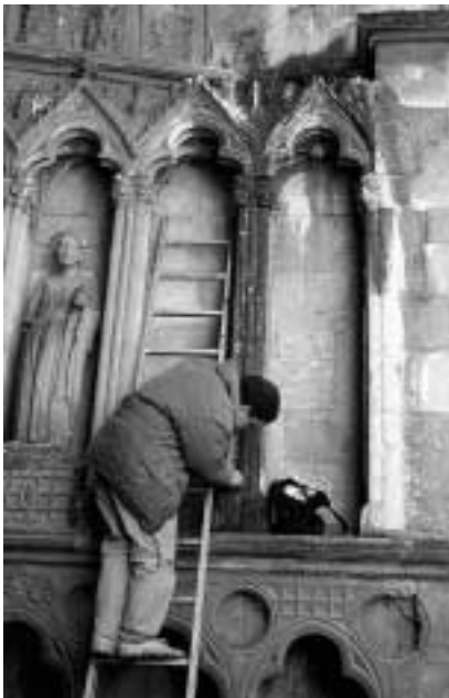
Imagen 246. Aspectos del muestreo. Pórtico de Santa Ana (punto de muestreo nº 7 y área afectada nº 11)
