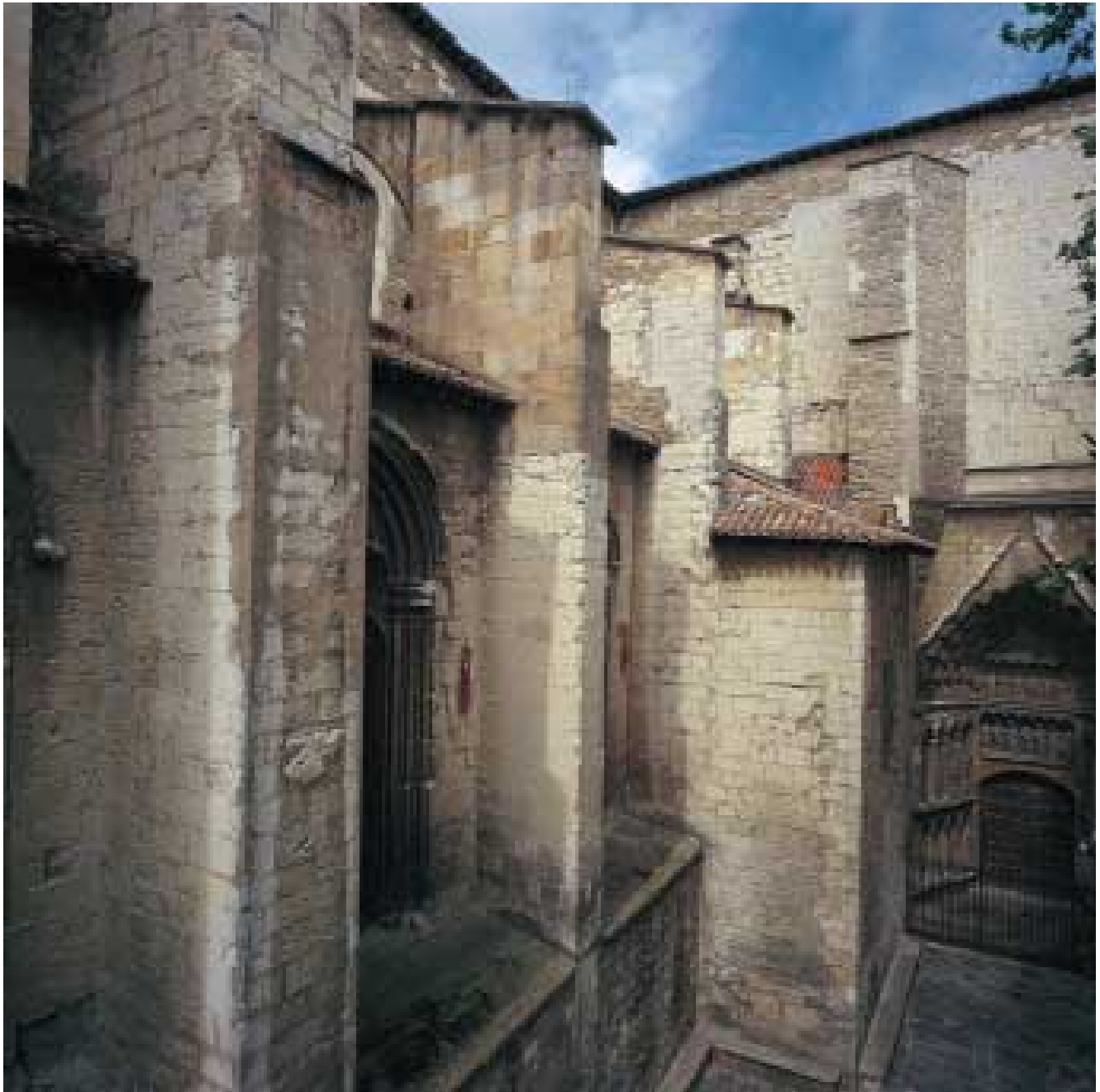
Imagen 154. La fábrica de la Catedral, vista general del transepto desde el SO. Sucesión de los botareles del alzado meridional y de fábricas de tipologías diferentes. Al fondo estribo del siglo XIX de la fachada occidental del transepto
