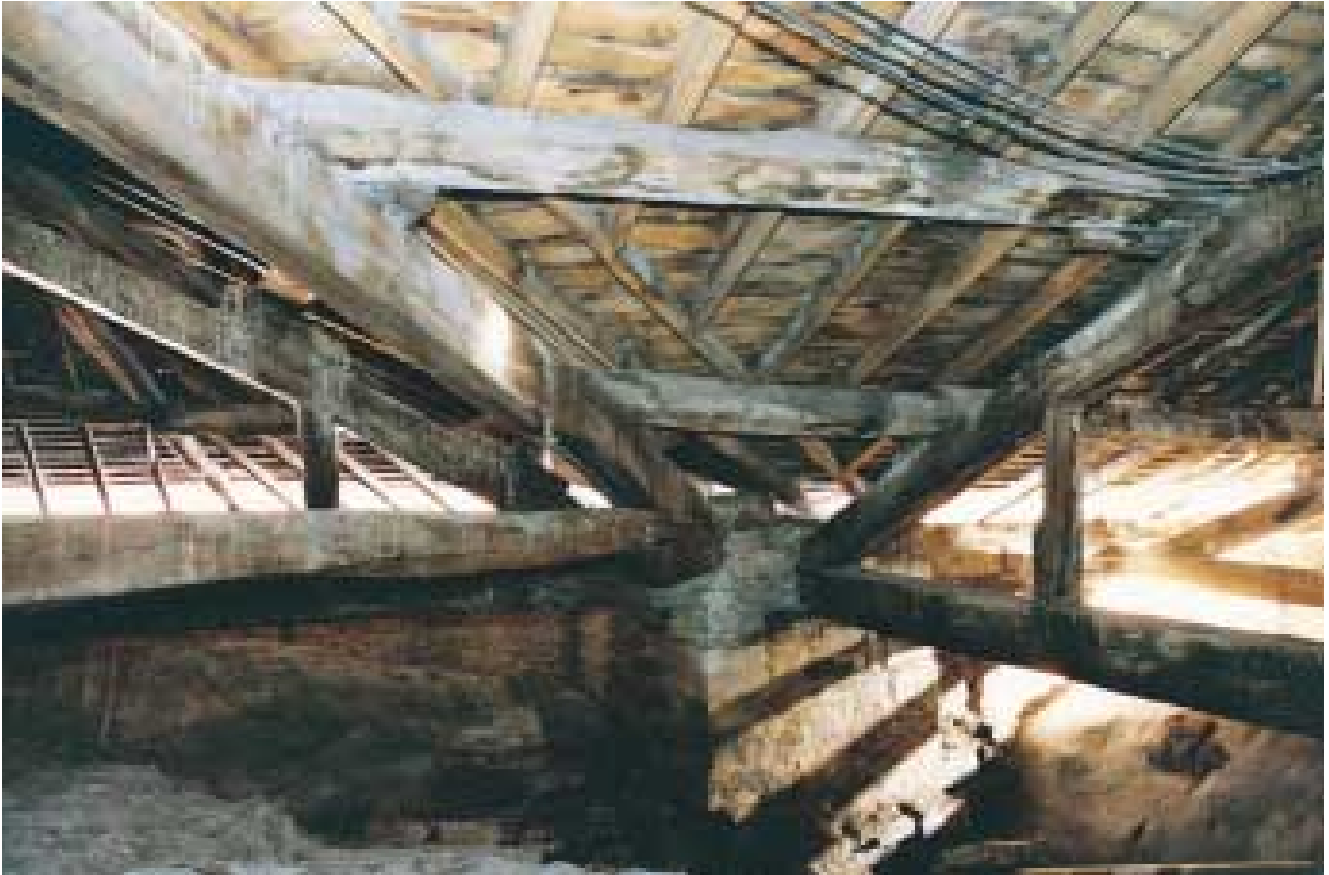
Imagen 275. Vistas de los apoyos de los cuchillos D1 y D2 en las pilastras. Apoyo en la esquina SE del crucero
