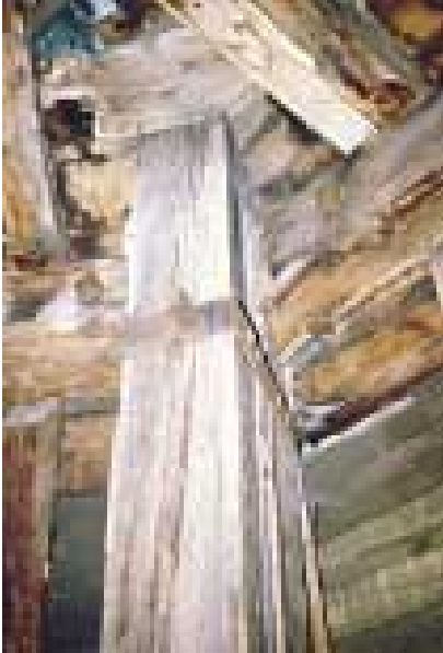
Imagen 316. Torre. Nivel 7. Unión con pasadores
