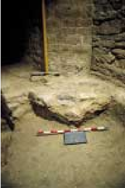
Imagen 94. Cimentación añadida para el inicio de la obra comenzada por Alfonso VIII
