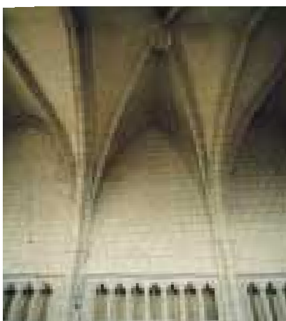
Imagen 205. Detalle de la pilastra y de las piezas de salmer en el arranque de los nervios de la bóveda en el muro occidental del 2º tramo del transepto sur
