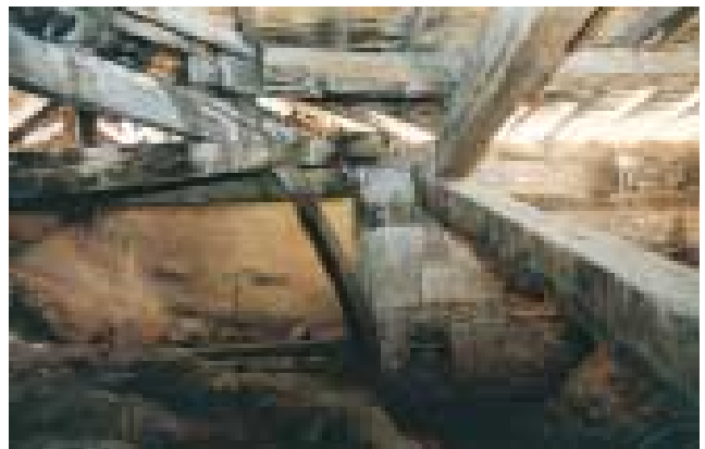
Imagen 277. Apoyo en la esquina SW del crucero
