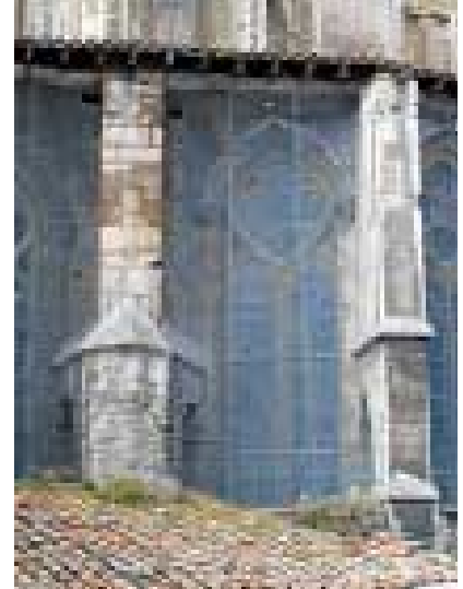
Imagen 195. Ventanal apuntado de la girola, época de Alfonso X, siglo XIII. A ambos lados detalle de los botareles inconclusos de este cuerpo de la edificación y que sirven de apoyo a la cubierta de madera del siglo XVII. El arranque de mampostería del botarel corresponde a la fábrica de Alfonso VIII, el desarrollo superior de sillería a la fábrica del primer gótico, época de Alfonso X, siglo XIII
