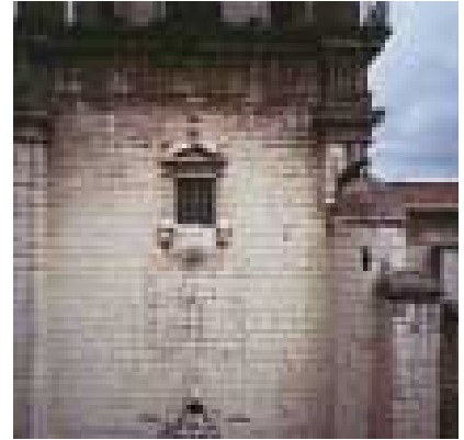
Imagen 185. Muro de una sola hoja de sillería, de lumaquela de Ajarte, de 30 cm de espesor que recubre un gran arco apuntado de mampostería en el fuste de la fachada sur de la torre, siglo XVI
