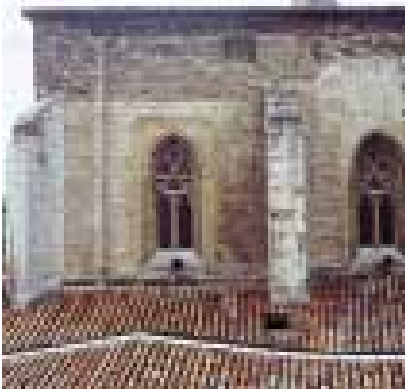
Imagen 193. Ventanal apuntado de piedra artificial, en el brazo norte del transepto, abierto en el siglo XX imitando los ventanales del siglo XIV. Ambos ventanales están enmarcados por muros de doble hoja de sillería del siglo XV a la derecha, y del siglo XVI a la izquierda. Por encima de estos muros se puede observar también, el muro de mampostería del siglo XVII construido para apoyar la cubierta de madera y el remate de fábrica de ladrillo y entramado de madera realizado en el siglo XX
