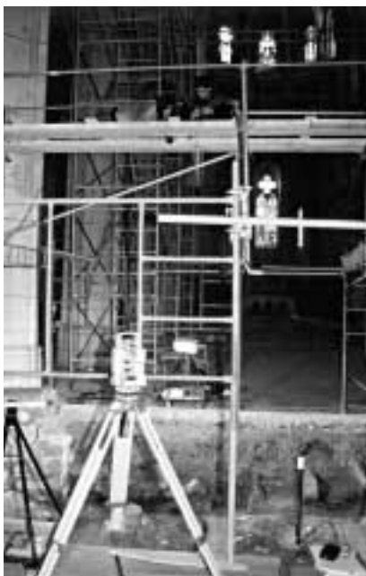
Imagen 33. Sistema de andamios sobre las excavaciones para la toma cenital de los fotogramas
