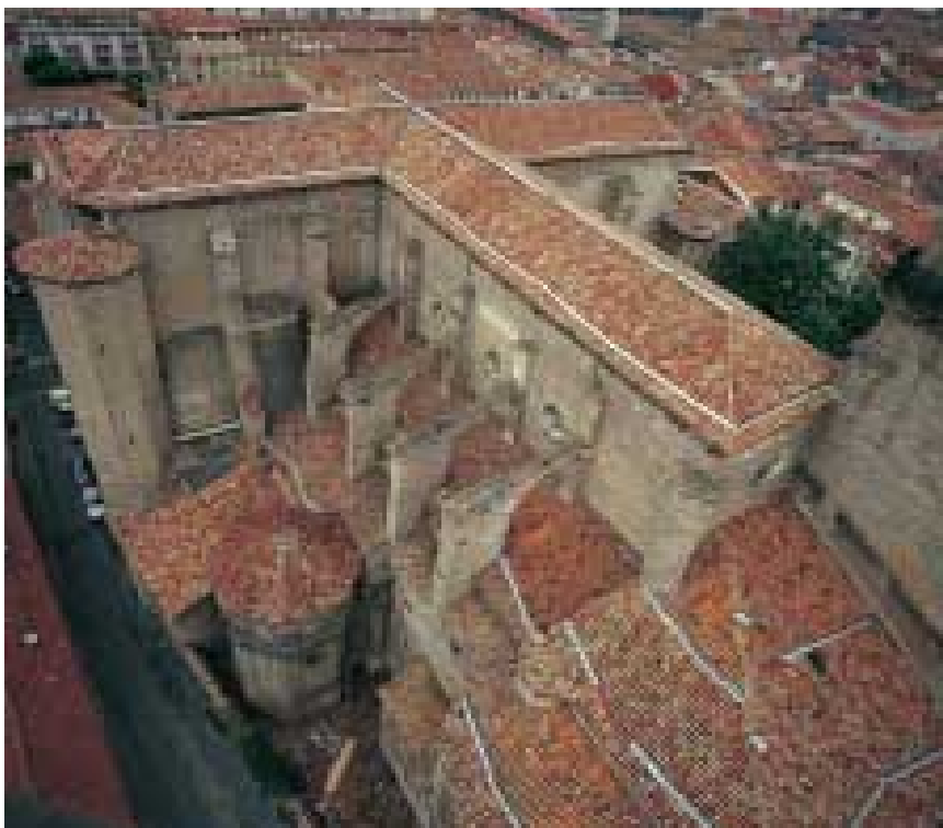
Imagen 218. Vista general de las cubiertas desde el noroeste
