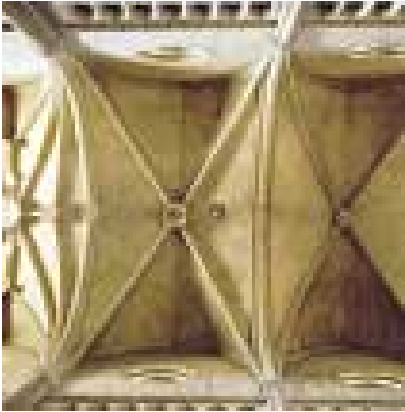
Imagen 214. Bóvedas del segundo tramo de la nave y el coro
