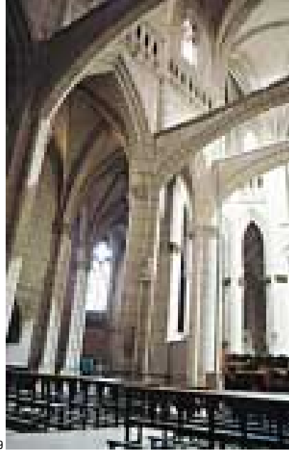
Imagen 508. Arcos codales de la nave central antes de su desmontaje en las restauraciones de la década de 1960. DFA. Archivo del Territorio Histórico de Álava. Fondo: López de Guereñu. Nº 3975
