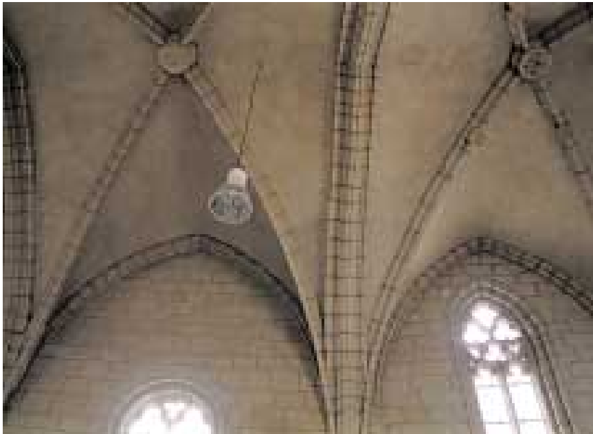
Imagen 430. Arranque de las bóvedas de la nave central sobre la pilastra norte entre los tramos cuarto y quinto. Se aprecia la diferente alineación de los dos paños de muro a un lado y otro de la pilastra provocada por el giro de ésta hacia el exterior –norte– debido al apoyo de su contrafuerte sobre el arco perpiaño de la nave central
