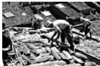
Imagen 598. Obras de reparación de la cubierta
