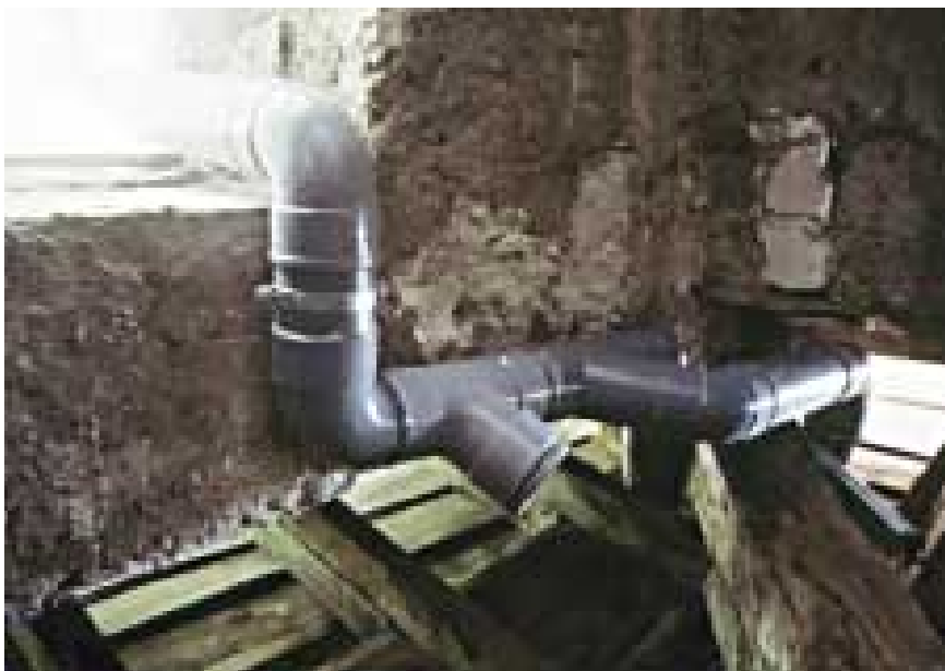
Imagen 597. Detalle de registro en un nudo al que acometen varios canales
