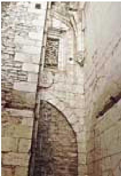
Imagen 439. Fondo sur de la amortizada capilla de Los Reyes, en el quinto tramo de la nave sur. Se aprecia el cegado de los vanos, el arranque de la demolida bóveda de terceletes y, a la izquierda, el gran machón de refuerzo del contrafuerte junto a la portada de Santa Ana, que se encuentra tras este muro del fondo
