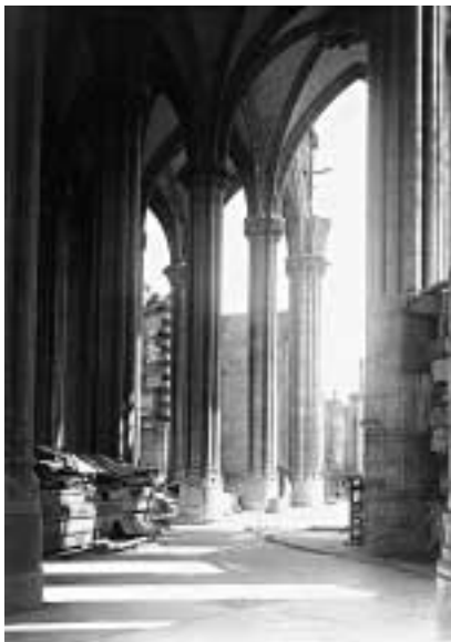
Imagen 75. La Catedral Nueva de Vitoria en construcción a principios del siglo XX. Foto Archivo Municipal de Vitoria-Gasteiz. Autor: E. Guinea. Ref: GUI-IV-125.3
