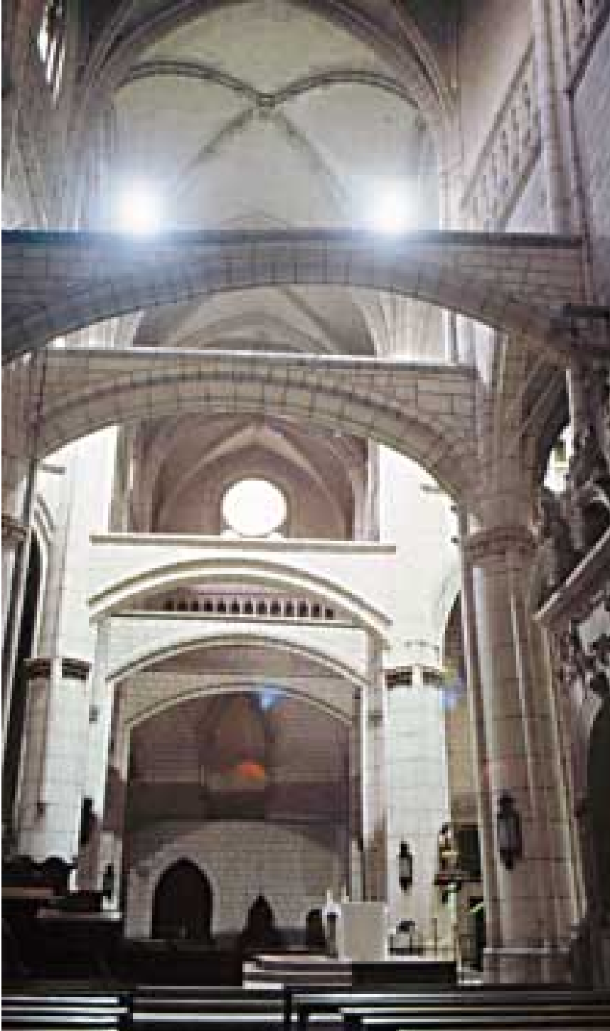
Imagen 440. Vista hacia el sur de la nave del transepto con los arcos codales que aún permanecen intactos. Se puede observar que todos ellos tienen distinta técnica de ejecución y diferente trazado
