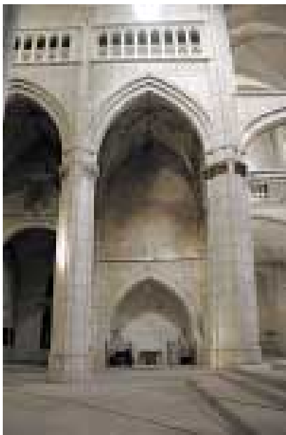
Imagen 426. Alzado del cierre norte del quinto tramo de la nave central, con el triforio escalonado y el pilar inclinado hacia el crucero –a la derecha–
