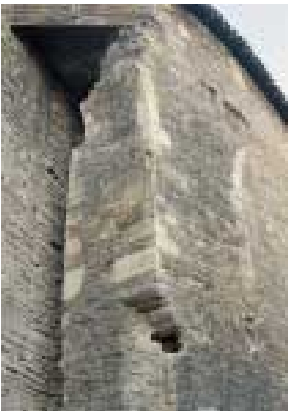
Imagen 9. Jamba y arranque de un arco que marcan el emplazamiento de la puerta más antigua documentada en la ciudad de Vitoria. Como puede verse tanto la jamba como las dovelas tienen una serie de refacciones, lo que nos permite pensar que esta puerta tuvo una vida útil más o menos dilatada
