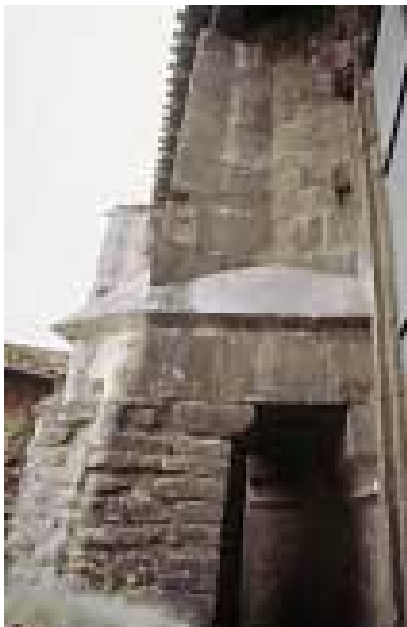
Imagen 411. Botarel exterior de la capilla sureste de la girola en el que se ve la diferencia de técnicas constructivas que marca las distintas fases históricas
