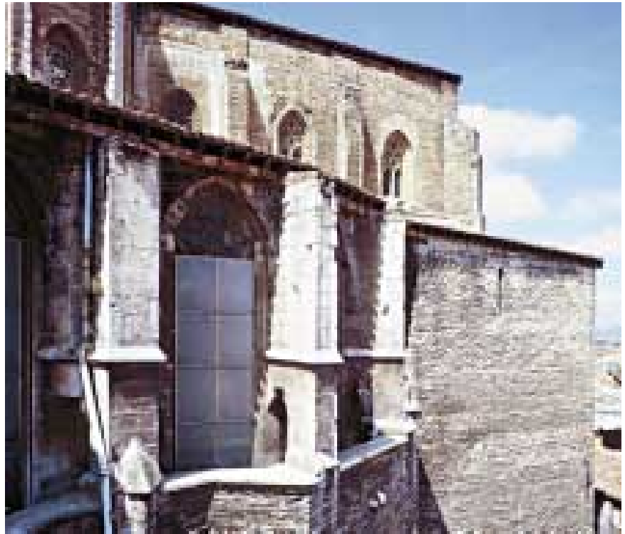
Imagen 88. Pasillo de ronda desde el este
