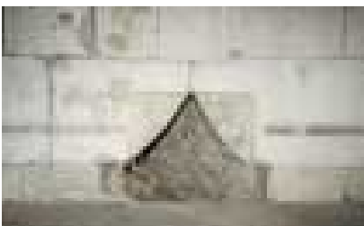
Imagen 17. Aspecto del forro de sillería que oculta por el interior de la iglesia los vanos de la obra iniciada por Alfonso VIII, una vez descubiertos tras la lectura estratigráfica
