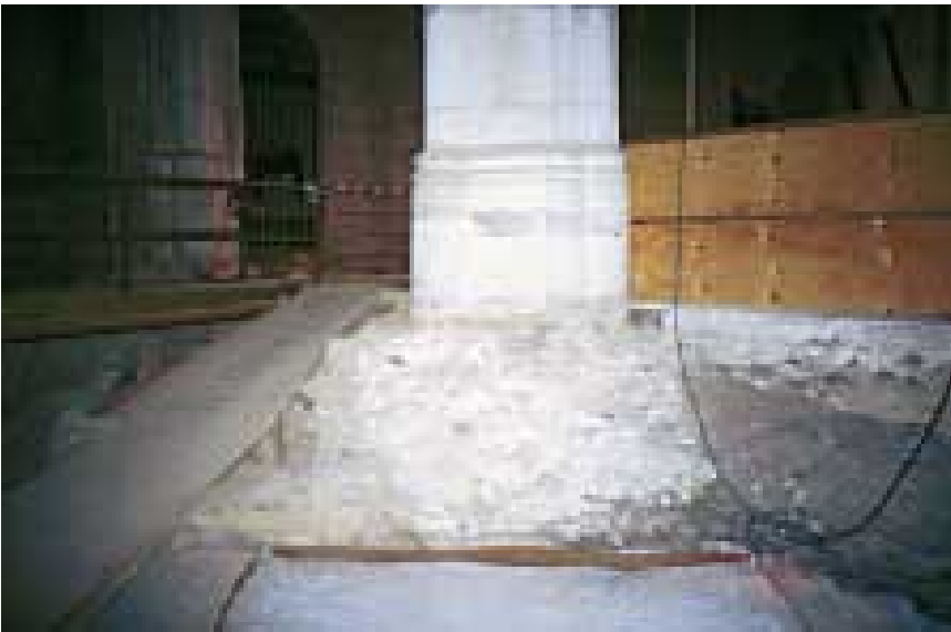
Imagen 520. Cimiento del segundo pilar norte de la nave central, ejecutado con fábrica masiva, sin aparejar y sin forma, en una estructura altamente compresible y degradable. Se aprecia también su mal apoyo sobre los restos de estructuras anteriores
