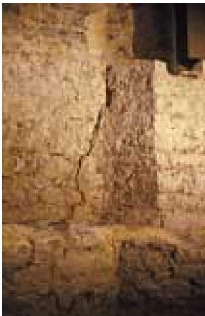
Imagen 409. Fisura descubierta al excavar las capillas de la girola. A la derecha de la foto se desarrolla la iglesia hacia el oeste. A la izquierda se encuentra el fondo del ábside dentro de la muralla del primer proyecto. La ladera descendiendo hacia este lado y la fisura denota un deslizamiento del muro de cierre en la dirección de la pendiente
