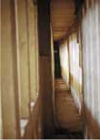
Imagen 423. Interior del ándito del triforio oeste del brazo sur del transepto. En primer plano, a izquierda y derecha, se aprecia el cambio de alineación de los muros debido al adelantamiento de los pilares del crucero
