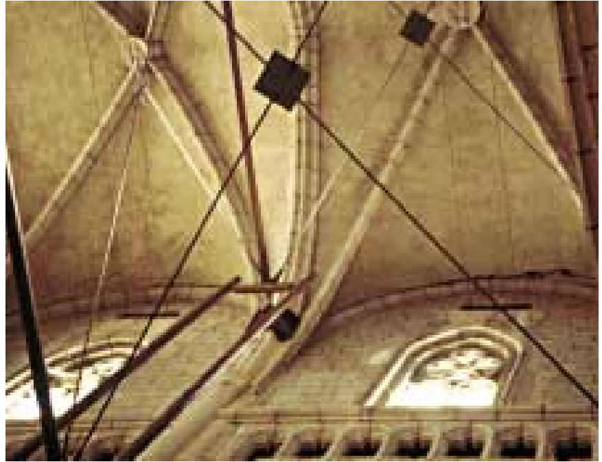
Imagen 517. Grietas entre las bóvedas del transepto norte y el muro oriental del mismo, sobre los formos
