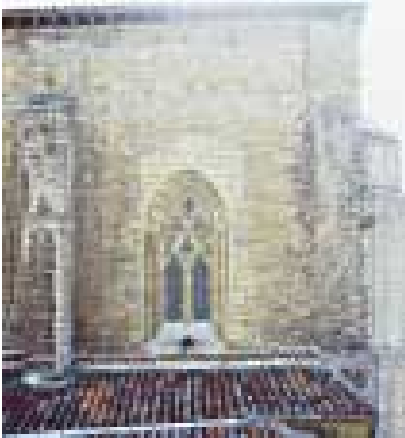
Imagen 67. Ventanal apuntado construido con la restauración de M. Lorente en la fachada oriental del transepto
