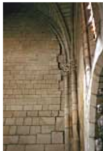
Imagen 503. Simétrica a la anterior, grieta en el extremo opuesto del mismo muro, junto al cierre exterior de la muralla, producida por la misma apertura del arco fornero
