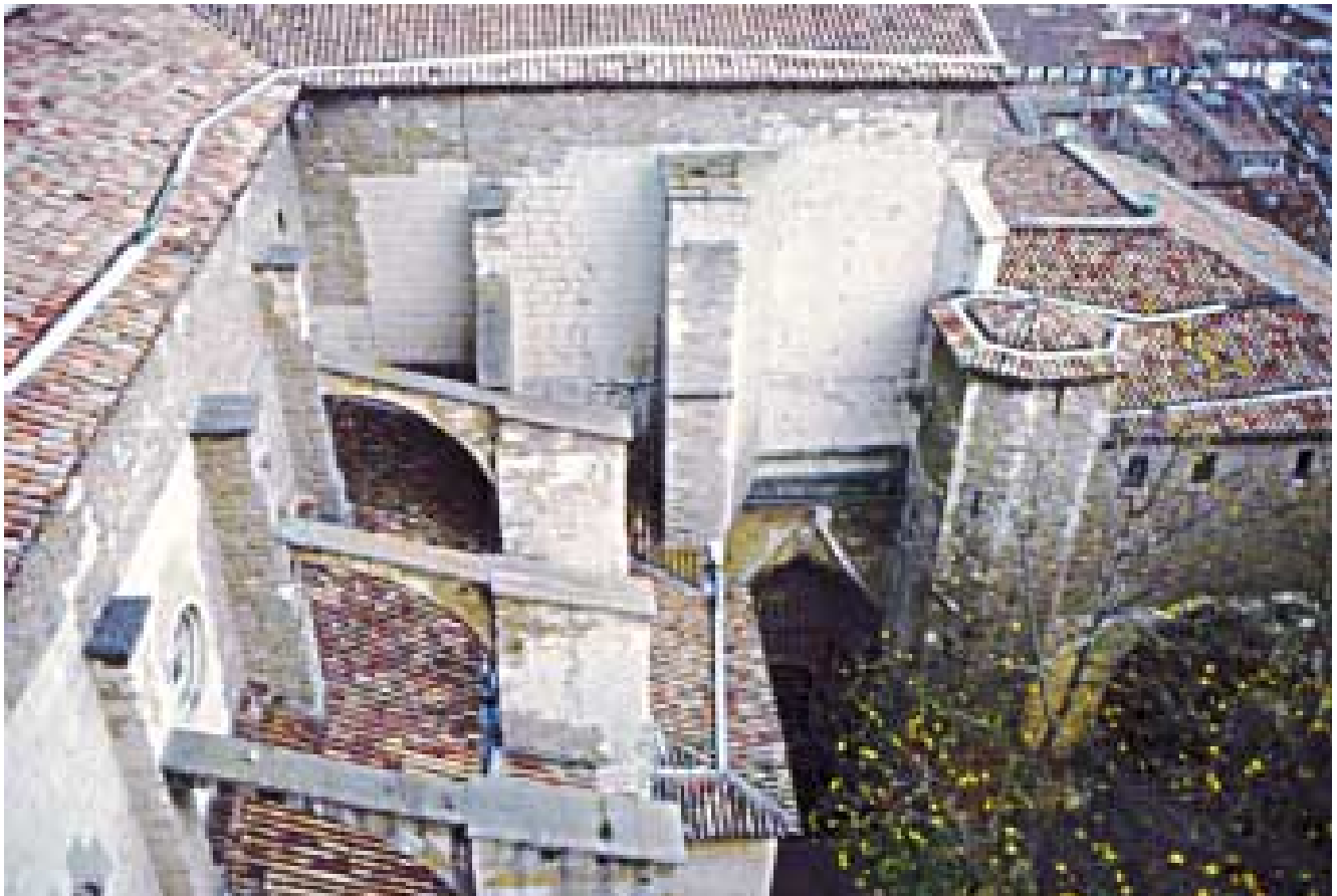
Imagen 443. Rincón suroeste de la Catedral, entre la nave central y el transepto sur –al fondo–. Se observa claramente la diferente técnica de ejecución del recrecido del muro del camaranchón de la cubierta, de mampostería sobre las fábricas inferiores, en general de sillería aunque a su vez formadas por distintas etapas. También se aprecia el sistema de contrafuertes, todos ellos distintos entre sí, y el resto del machón que reforzaba y ocultaba la portada de Santa Ana
