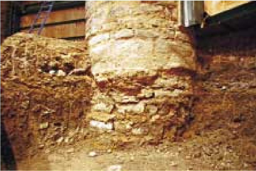
Imagen 519. Cimiento de un pilar del presbiterio descubierto en la excavación arqueológica de la girola. Se aprecia su construcción mediante lajas de caliza margosa y juntas muy anchas de mortero altamente plástico, con la aparición de una fisura horizontal, posiblemente debida al giro del cimiento
