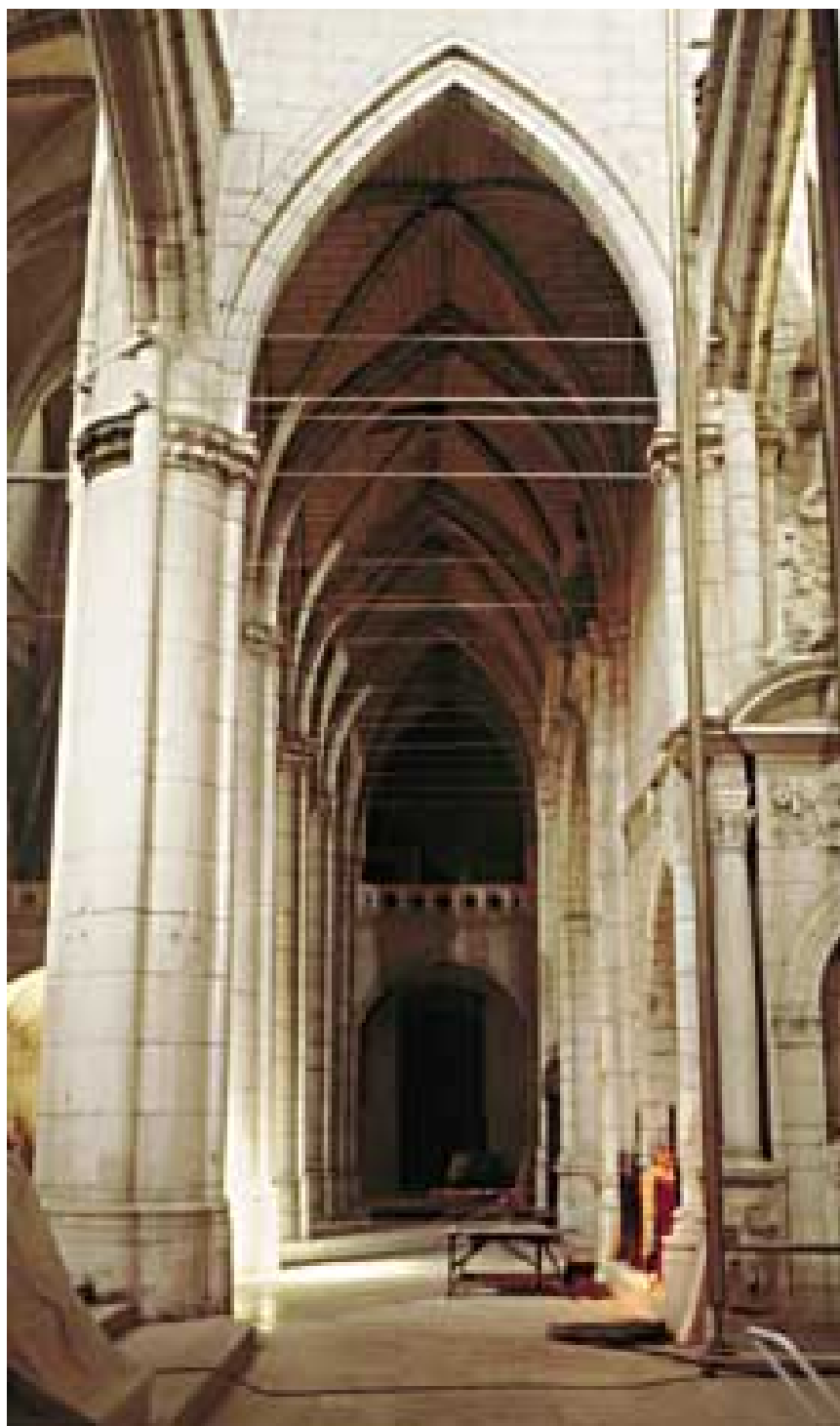
Imagen 452. Vista de la nave norte desde el transepto. Se puede ver la sucesión de los tirantes de los arcos perpiaños, cuatro por cada arco, dispuestos durante la restauración de 1960-65 para sustituir el efecto centrador de las cargas en los pilares de la nave que era producido por los arcos codales desmontados entonces
