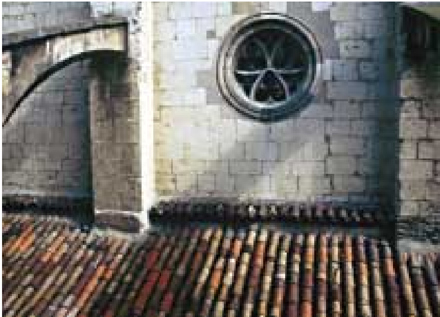
Imagen 481. Detalle de la fábrica de sillería del muro sur de la nave central. Deterioro de los materiales
