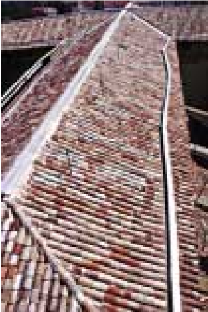
Imagen 592. Cubierta de la nave de la Catedral después de la intervención
