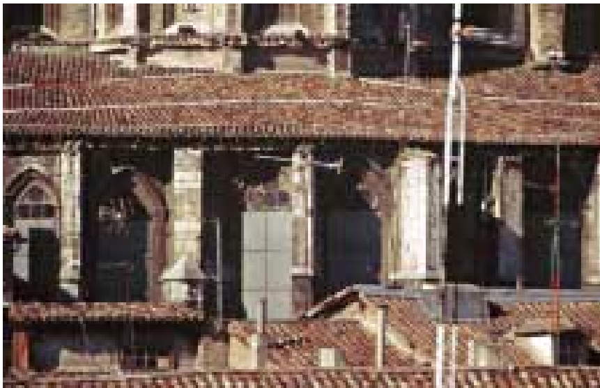
Imagen 415. La girola desde el este. Se ven los botareles mochos correspondientes a la primera etapa gótica y, entre ellos, los ventanales de tracería de las capillas absidales
