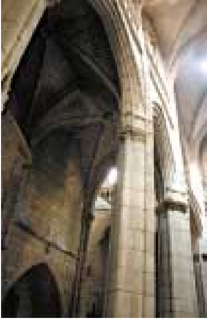
Imagen 491. Pilares cuarto y quinto de la arcada norte de la nave central, con su forma sinuosa
