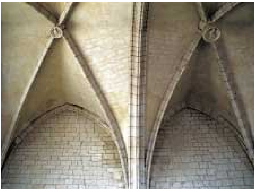
Imagen 348. Bóvedas del primer y segundo tramo del transepto sur, hacia oeste. Se aprecian las grietas que separan los plementos y arcos formeros del muro
