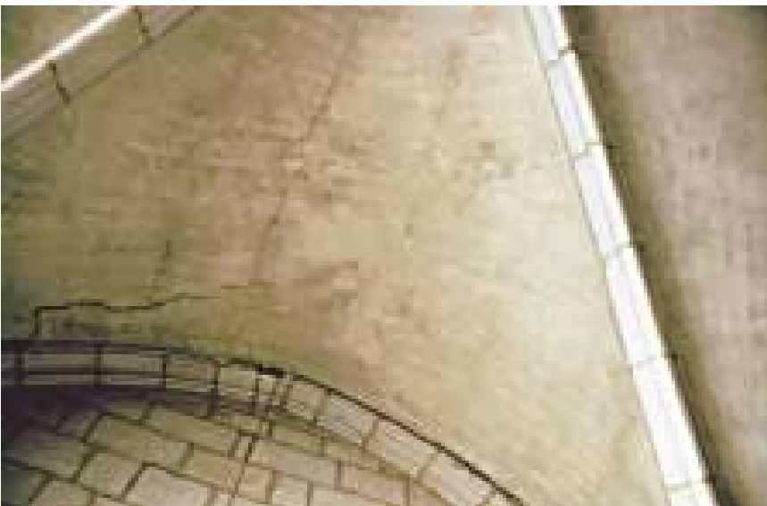
Imagen 488. Formación de grietas en los plementos sobre la portada de Santa Ana. Se aprecia la grieta transversal a la directriz de la bóveda en su clave y la perpendicular a ella, junto al arco formero
