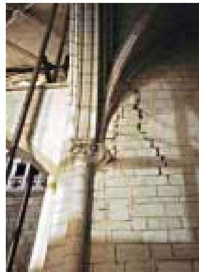
Imagen 501. Grieta en el muro medianero de las capillas del brazo norte del transepto, junto a la pilastra de la nave, producida por la apertura del arco fornero
