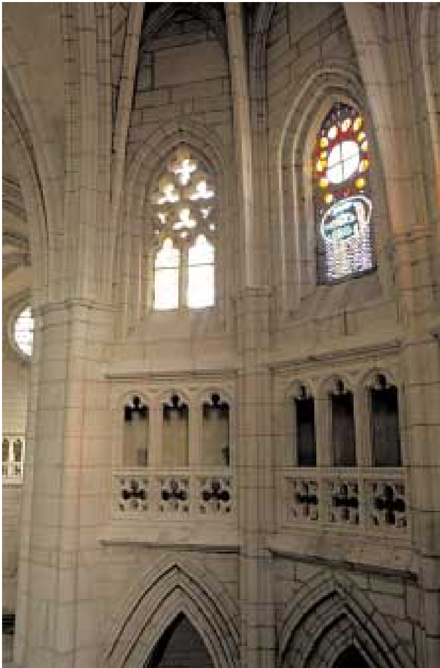
Imagen 417. Arranque de los arcos perpiaños y ojivos del presbiterio y el crucero sobre el pilar noreste. Se aprecia cómo el tas de charge se construye junto con el muro y los ventanales y las piezas de los arcos y los salmeres acuerdan perfectamente con el arranque
