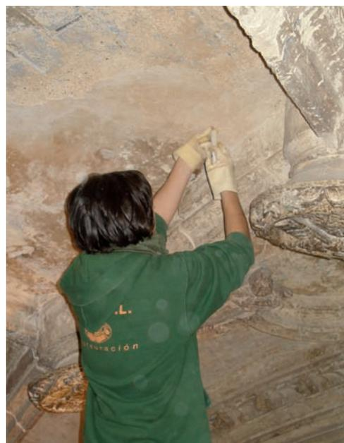
Inyección de lechada de cal hidráulica en un plemento.
