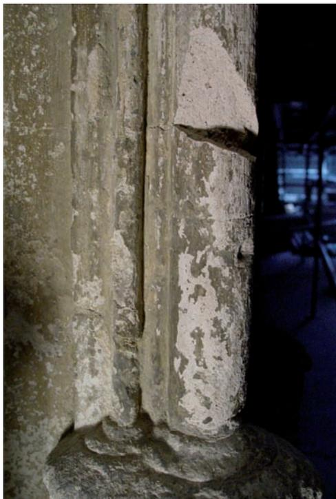
Mortero de reposición volumétrica de la parte baja, basamento. Muro frontero.
