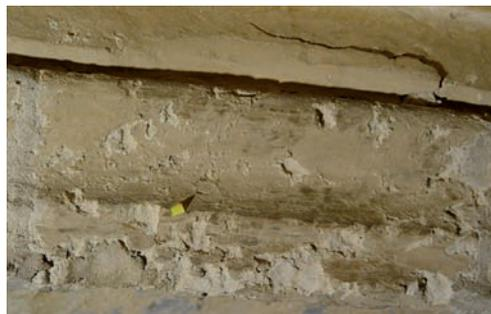
Detalle del estado de conservación de un nervio de la bóveda.
