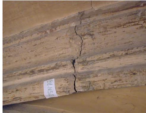
Mortero de junta repuesto con cemento, en la bóveda 1, nervio 52.
