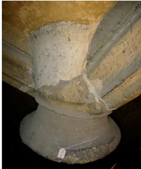
Detalle de los morteros de reconstrucciones volumétricas en el tronco de la clave (B4-C08).
