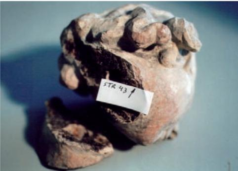
Detalle de la reparación con perno de plomo y brea, cabeza del ángel en las arquivoltas del tímpano 2 (P2-A05-E10).
