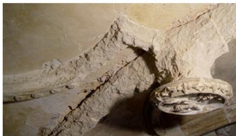
Estado en que se encontraron el nervio y la clave de la bóveda 3 tras la eliminación de las reposiciones antiguas. En este caso fue preciso sustituir las dovelas que habían perdido su función estructural.
