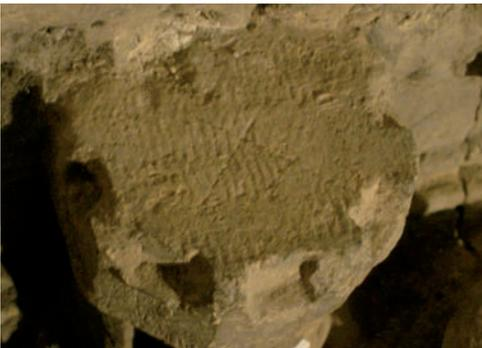
Remate superior en la portada 1, tímpano 1 del registro 1, donde se aprecian las trazas previas al desbaste del bloque de piedra.
