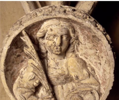
Estado de conservación de una clave después de la eliminación del revestimiento policromo.
