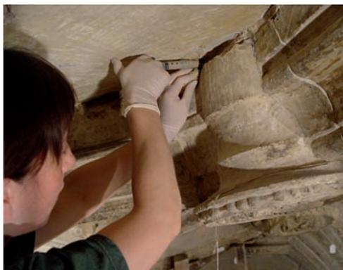
Inyección de mortero de cal hidráulica en clave descolgada.
