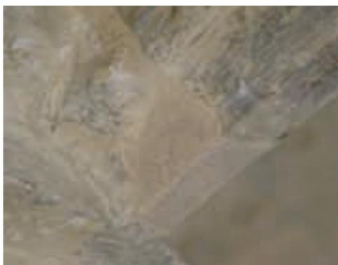
Img. 7.10. Detalle de una junta con su mortero de acabado.
