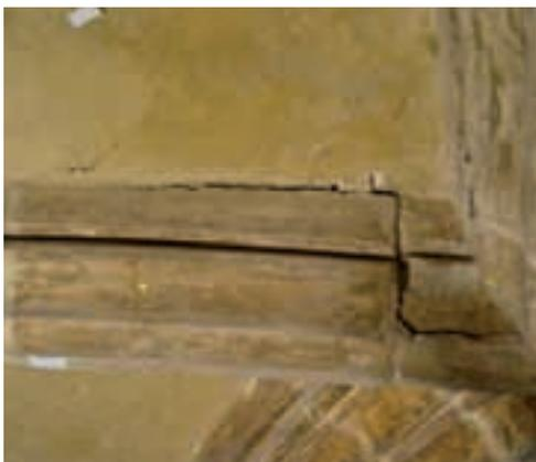
Img. 7.2. Imagen de pieza descolgada junto al arranque de la bóveda.
