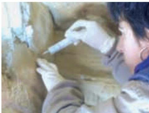
Img. 7.16. Inyección en revestimientos desprendidos.
