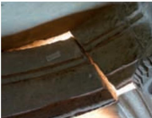
Img. 7.1. Imagen de pieza descolgada junto a la clave.
