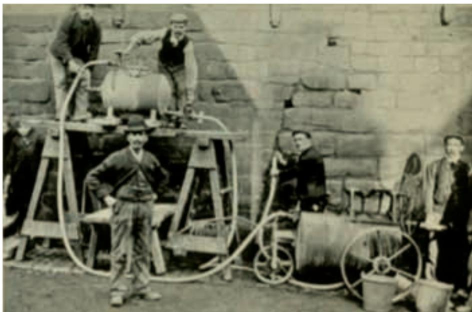
Figura. 4.6. Hacia 1870. Fotografía de Sir Francis Fox, Chester (Inglaterra), antiguo muro y torre de agua. La máquina de inyección de Greathead (James) siendo aplicada por primera vez en la salvación de edificios antiguos.
