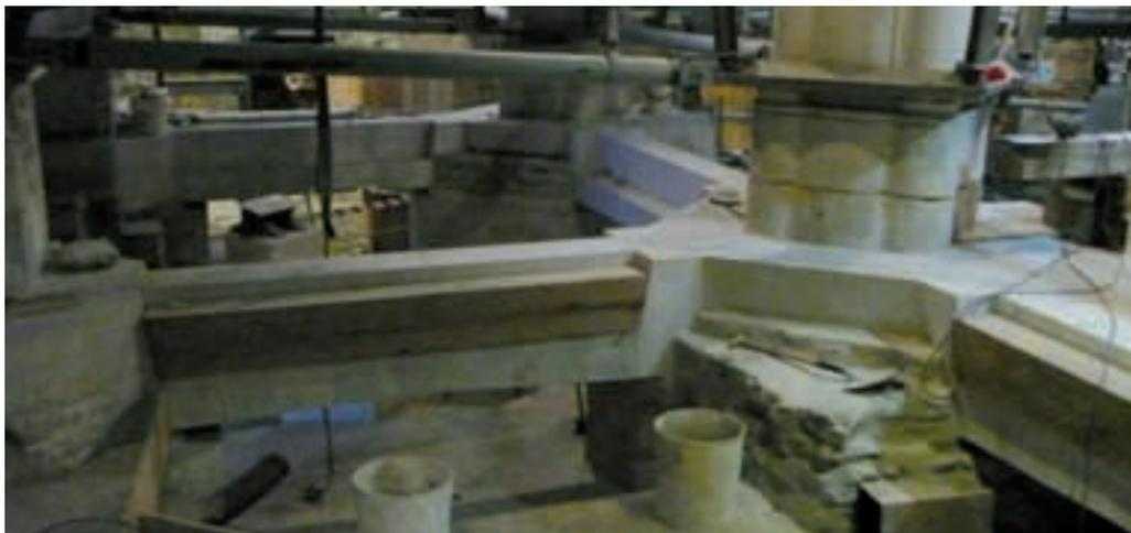
Img. 1.18. Arcos codales entre los pilares de las naves, encamisado de las bases mediante muros de mampostería y cadenas de cantería. Se aprecian las durmientes para la estructura del forjado que apoya en los arcos.
