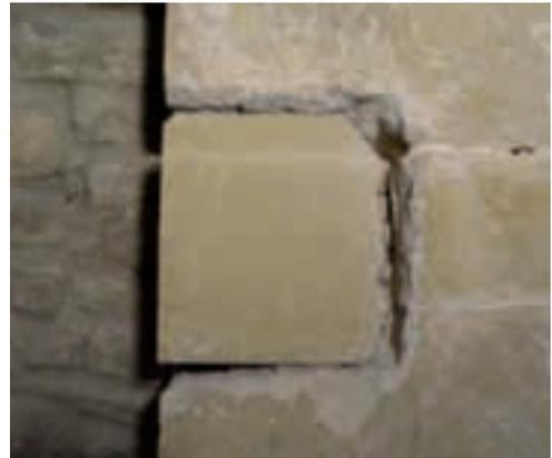
Img. 7.5. Ejemplo de junta en la que tras eliminar la junta de cemento han quedado grandes huecos.
