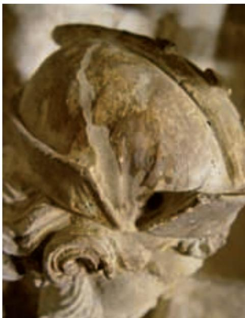
Img. 7.12. Cerrado de fisuras con mortero de cal aérea y áridos muy finos.
