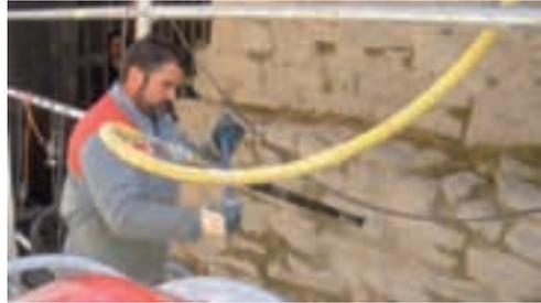
Img. 6.16. Apretado del obturador metálico para ajuste y sellado del orificio.
