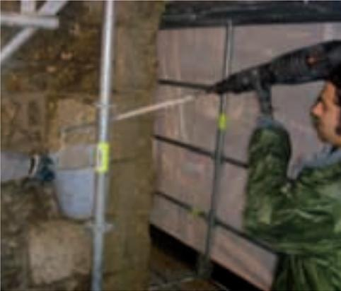
Img. 3.13. Ejecución de perforación por rotoperCUSión.
