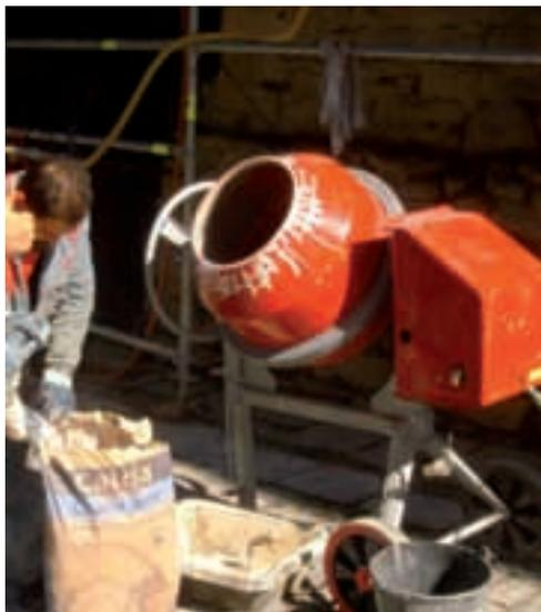
Img. 6.8. Preparación de la mezcla con la introducción de los componentes en la hormigonera.
