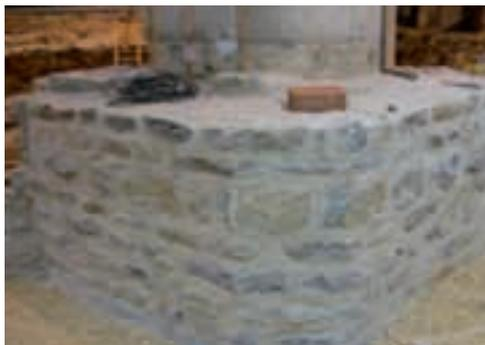
Img. 4.3. y 4.4. Año 2003. Encamisado de pilares, F1 con hormigón y G2 con anillo de mampostería.
