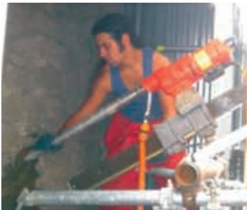
Img. 3.11. Ejecución de perforación con corona de diamante.
