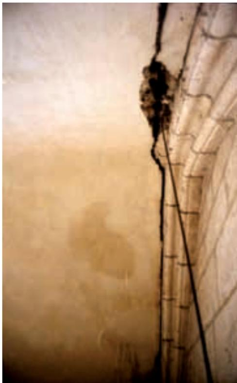
Img. 1.14. Fisura de separación entre bóveda y muro en el brazo sur del transepto, donde se aprecia el hueco dejado por la caída de parte del revestimiento.
