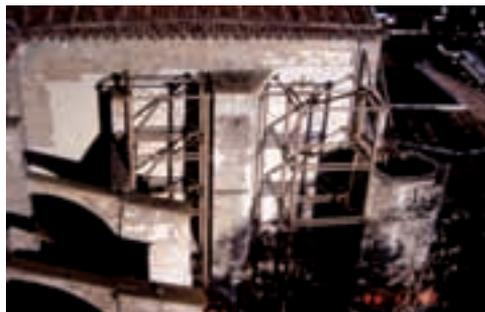
Img. 6.68. Imagen exterior del crucero norte con los castilletes de apeo colocados en el año 2003.
