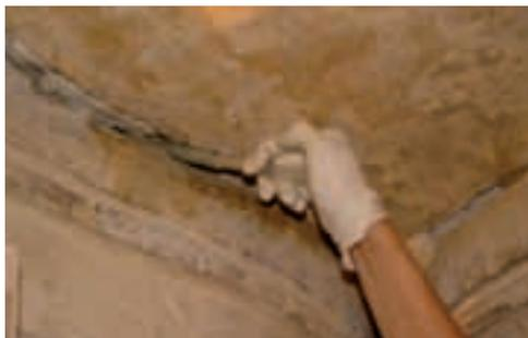
Img. 7.3. Inyección de mortero y lechada de cal hidráulica mediante jeringuillas cortadas, con una prolongación de un tubo de 1cm de diámetro aproximadamente.
