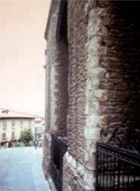
Img. 1.16. Machones exteriores del pórtico. En primer plano el que soporta la torre ha sufrido fractura de todos sus sillares esquinales por aplastamiento de la fábrica, mientras que, en el de más atrás, estos se encuentran en perfecto estado.
