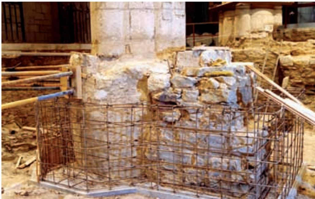
Img. 6.46. Armadura de acero inoxidable utilizada para la consolidación de urgencia del pilar F1 (Quintas fotografías).
