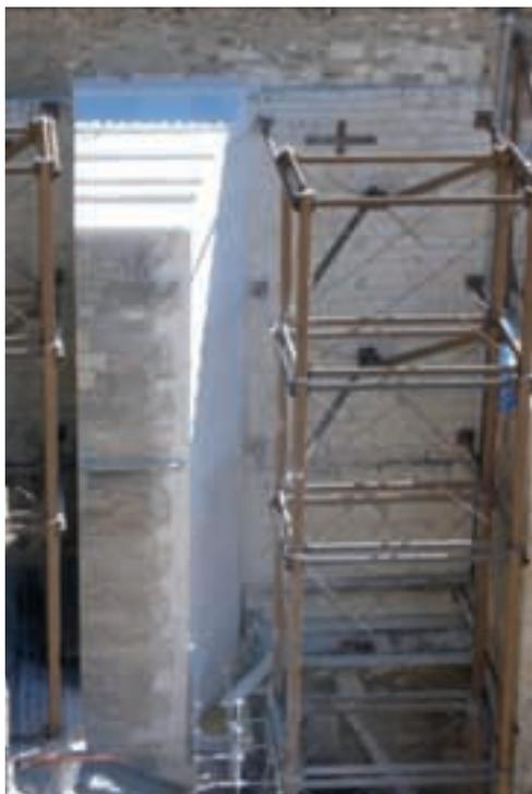
Img. 1.17. Reparación del contrafuerte junto al portal de Santa Ana, en el brazo sur del transepto, mediante un refuerzo lateral con sillería. Se aprecian las estructuras metálicas de contrarresto dispuestas provisionalmente para evitar el aumento de los desplomes del muro.
