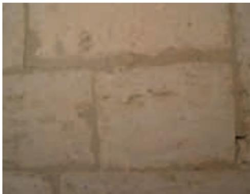
7.7. Juntas de cemento fisuradas y separadas del material pétreo original, que ya no cumplen su función.
