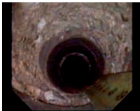
Img. 6.7. Endoscopia. Se aprecia la junta de mortero de cal con caliches en perfecto estado. A la derecha el flexómetro para control de profundidad.
