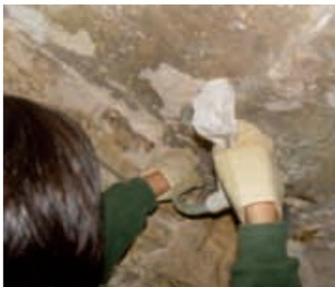
Img. 7.4. Inyección de mortero y lechada de cal con manga.
