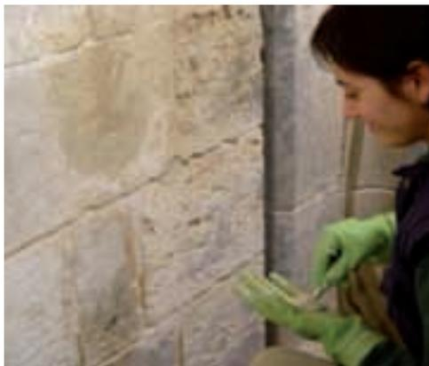
Img. 7.9. Colocación de mortero de acabado de cal aérea en juntas y alveolo.
