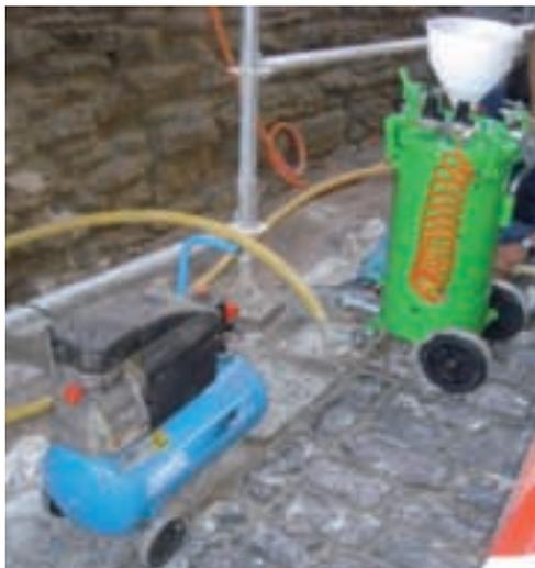
Img. 6.13. Sistema de inyección con compresor en primer plano, calderín en verde y manguera sin llave de corte ni obturador.
