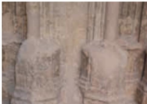
Img. 7.14. Cerrado de desgastes y erosión de superficie con mortero de cal aérea y áridos muy finos.
