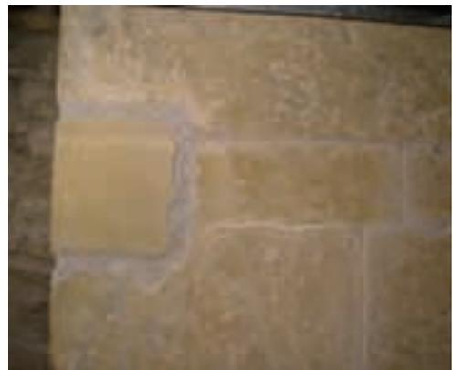
Img. 7.6. Resultado tras la aplicación de mortero de relleno. El mortero se ha rallado y se ha dejado entre 1-2 cm por debajo del nivel del material pétreo para permitir colocar los morteros de acabado.
