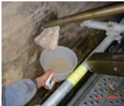
Img. 3.12. Sistema auxiliar provisional de recogida y evacuación de agua de perforación.
