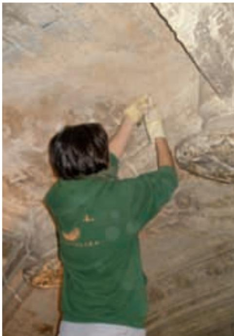
Img. 7.15. Inyección en revestimientos desprendidos.
