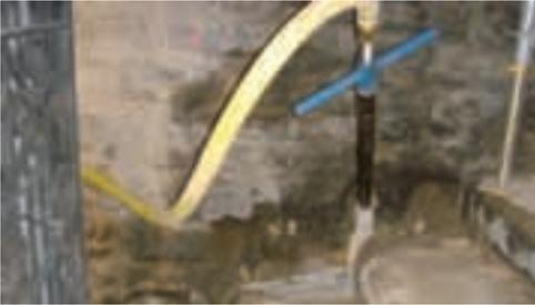
Img. 6.15. Obturación defectuosa sin llave de corte en punta y sin sellado perimetral.
