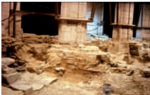
Img. 4.1. Cimentación de pilares de la nave norte durante la excavación arqueológica.
