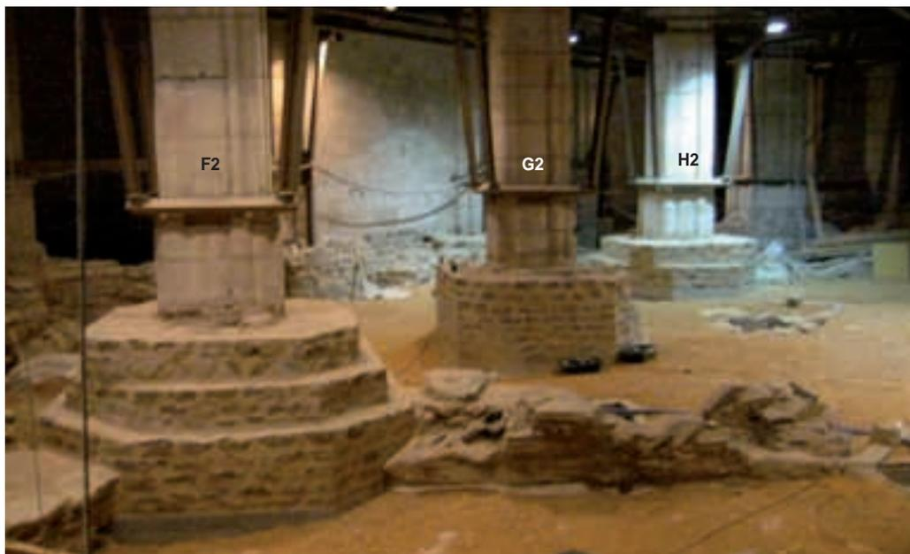
Img. 6.53. Anillos de mampostería colocados sobre la cimentación de los pilares F2, G2 y H2.
