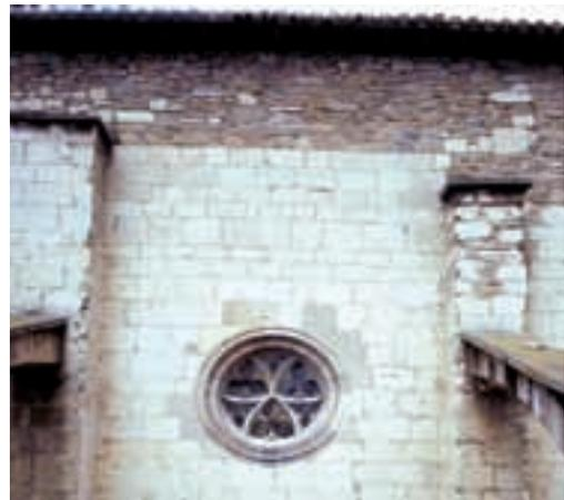
Img. 2.26 y 2.27. Interior y exterior del muro de mampostería de dos caras con sillares reutilizados.
