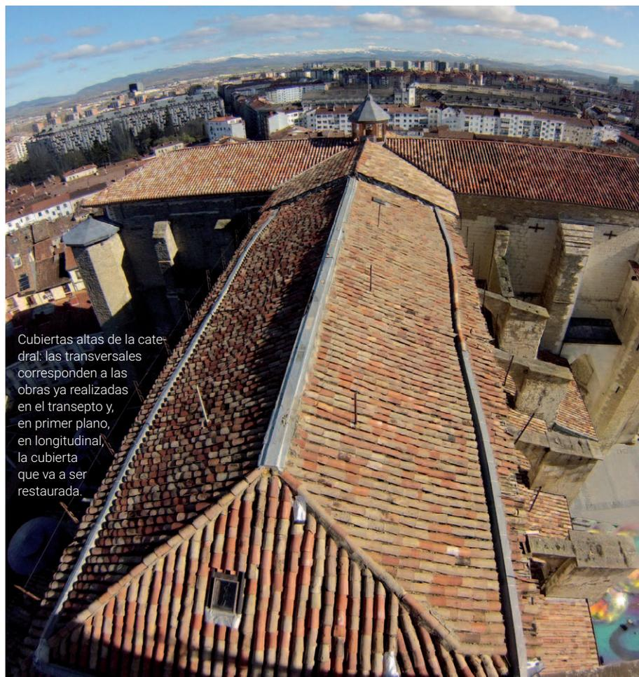
Cubiertas altas de la catedral: las transversales corresponden a las obras ya realizadas en el transepto y, en primer plano, en longitudinal, la cubierta que va a ser restaurada.
