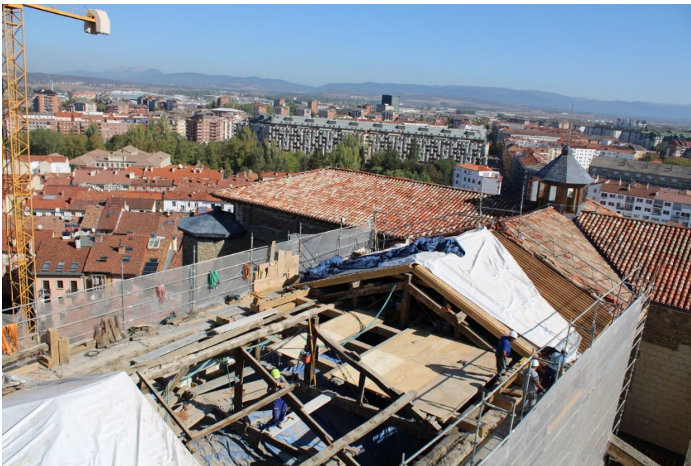
Obras en la cubierta de la nave
