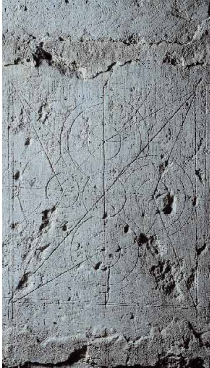
Marcas de compás para trazas de cantería.
