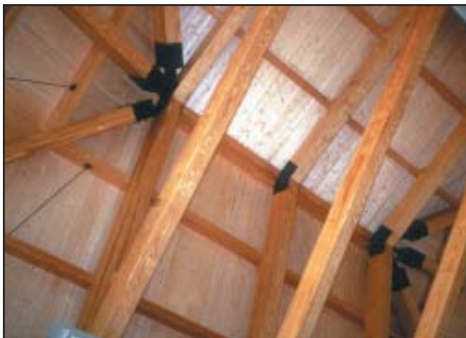
Vista de la nueva cubierta de madera desde el interior
