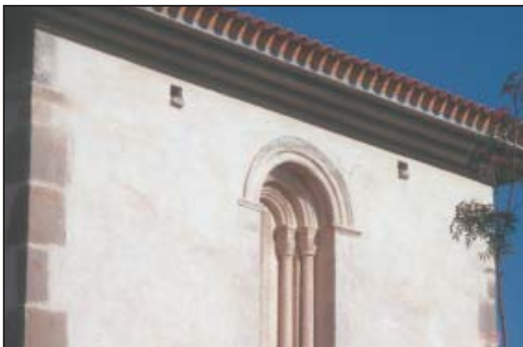
Detalle de la fachada este restaurada con la ventana románica
