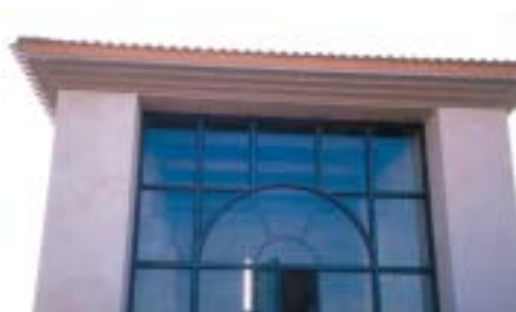
Detalle del alero y el cierre acristalado
