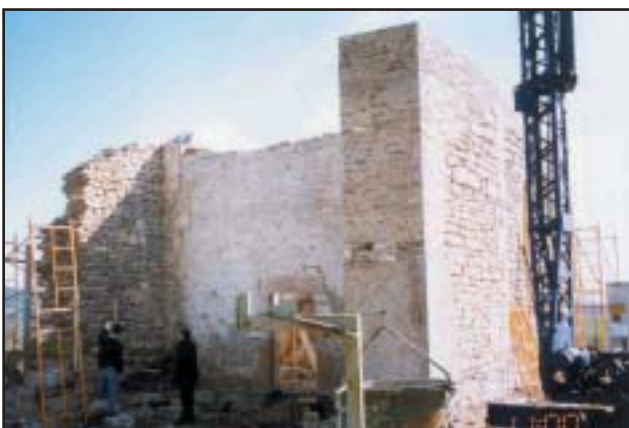
Durante la obra: El cierre oeste a demoler, entre los muros norte y sur.
