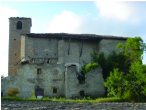
Foto 4 Fachada sur, con edificaciones anexas arruinadas.
