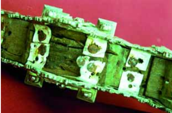
Sistema de anclaje con clavos de hierro totalmente oxidados
